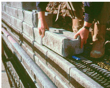
Dễ dàng lắp đặt khối bê tông TW1 và lưới địa kỹ thuật Tensor.
