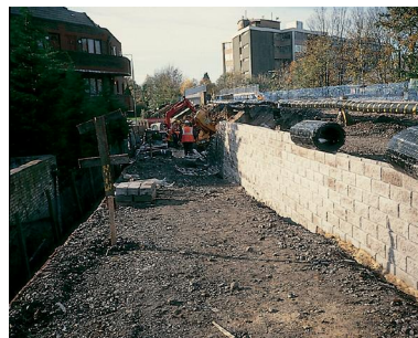
Khối bê tông làm bề mặt tường để lắp đặt và liên kết đơn giản nhưng chắc chắn.
