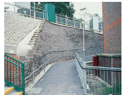
Kết cấu đẹp mắt được thi công nhanh và tiết kiệm hơn các phương pháp thông thường khác.
