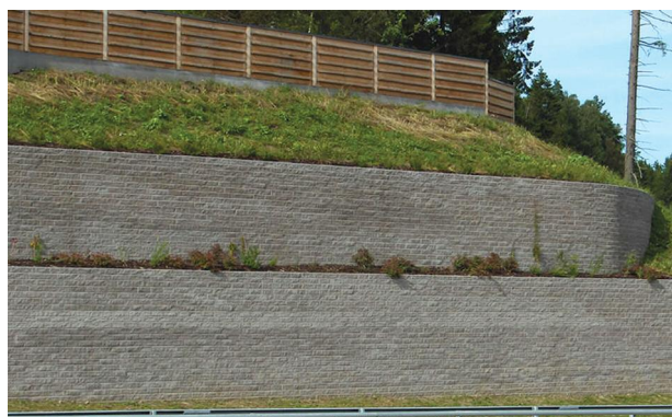
Thi công kết cấu công trình đường cao tốc có vòng đời thiết kế là 120 năm.
