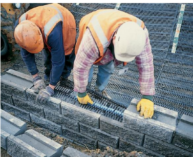
Thi công thẳng đứng và không cần phải có kỹ năng chuyên nghiệp hoặc thiết bị thi công.
