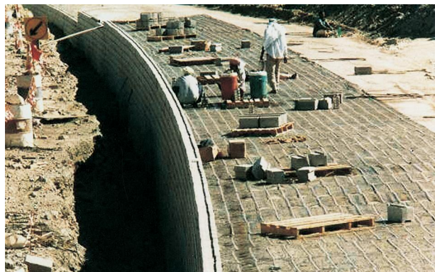
Công trình này ở Các Tiểu Vương Quốc Ả Rập Thống Nhất cho thấy rằng có thể xây Hệ Tường TW1 Tensartech mà không có cần cầu hoặc thanh chống.
