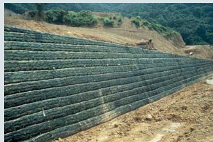
Khi thi công xong, có thể chuẩn bị trồng cỏ trên mái dốc.
