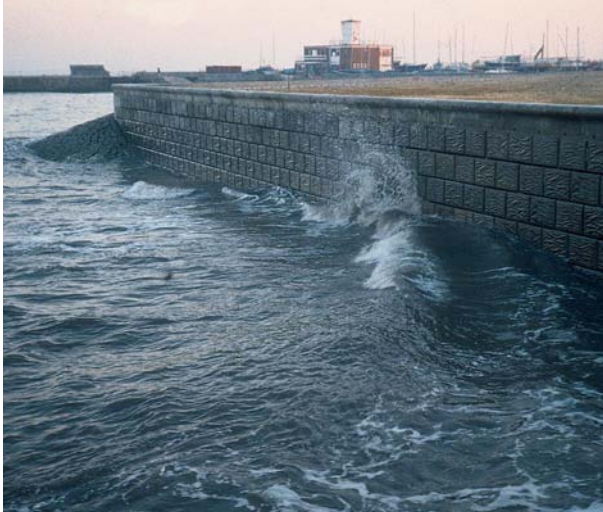
Tường Tensar bề mặt hạng mục công trình thủy rất phù hợp với các điều kiện biển động mạnh như khu vực cảng này
