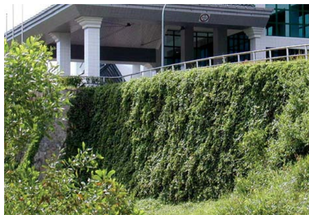
Trồng cỏ bề mặt tường chắn tiết kiệm đến 75% chi phí so với các phương án thi công thông thường
