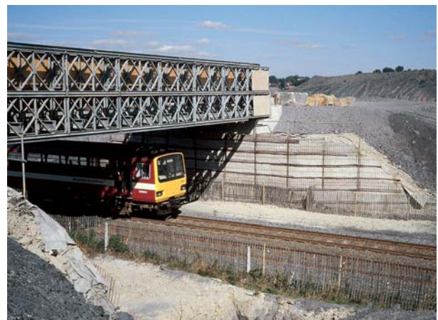
Hệ thống Tensar thường được sử dụng để thi công các mô cầu tạm có chi phí thấp.
