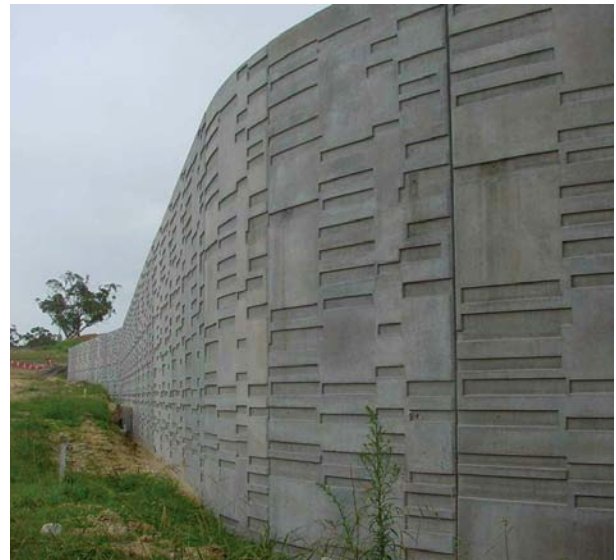
Có thể tạo ra nhiều bề mặt có hình hoa văn hoặc kết cấu giảm chấn bằng cách sử dụng các hệ gá và các phương pháp xử lý
