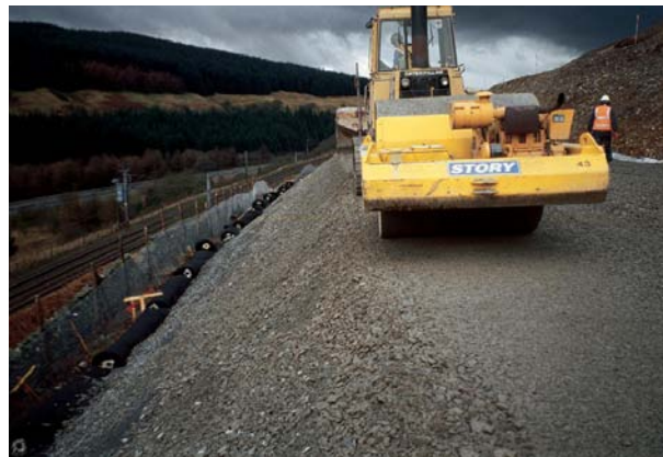
Máy đầm siêu trọng có thể hoạt động sát ngay bề mặt của mái dốc 1:1
