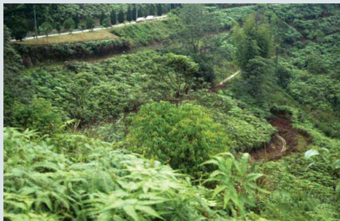
Các Hệ thống Mái dốc Tensar không những ổn định mà còn tạo bề mặt có vẻ đẹp tự nhiên
