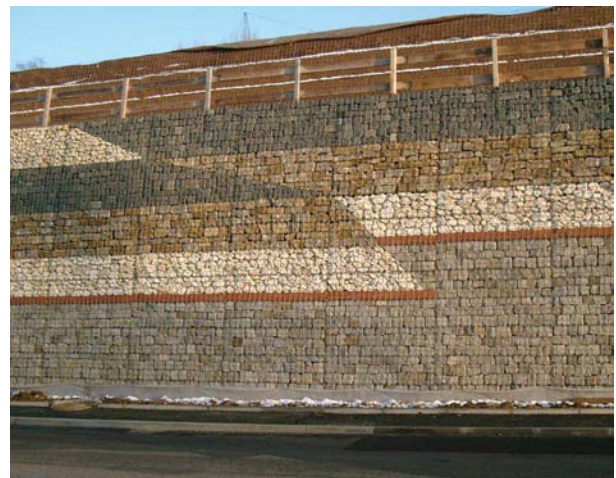
Tensar có thể tạo ra bề mặt một kết cấu rọ đá với chi phí thấp bằng cách sử dụng đất gia cố
