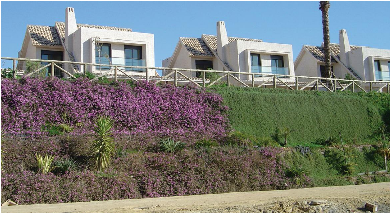
Trồng cỏ bề mặt tường chắn tiết kiệm đến 75% chi phí so với các phương án thi công thông thường
