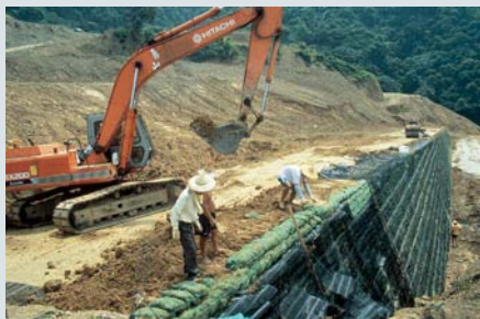
Thi công chỉ sử dụng lưới địa kỹ thuật Tensar cùng với thiết bị và vật liệu sẵn có, giảm đến mức tối thiểu chi phí và thời gian thi công.
