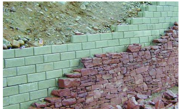
Có thể dễ dàng có được bề mặt dạng đá bằng cách sử dụng hệ tường gạch block với các dây thép không gỉ.
