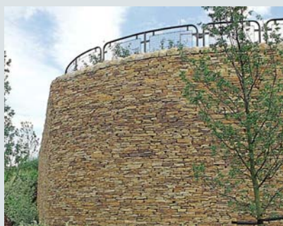
Bề mặt tường đá xây
