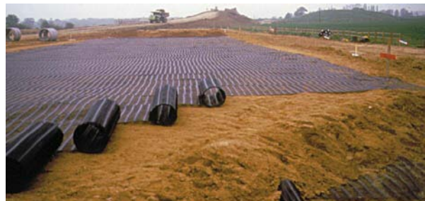
Gia cố nền đắp của một đường cao tốc
