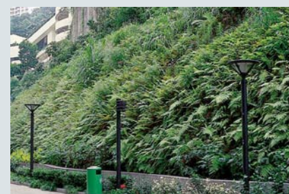
Mái taluy gia cố bằng lưới thép với bề mặt cỏ mọc tốt sau khi thi công (Hồng Kông)
