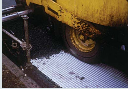
Rải lớp áo nhựa trên bề mặt lưới địa kỹ thuật Tensar
