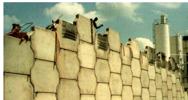
Tường chắn ghép từ các panel bê tông đúc sẵn.
