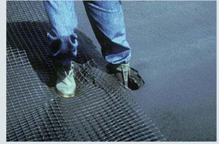
Thi công an toàn
