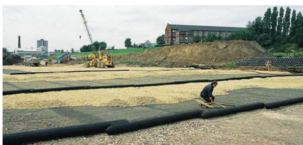
Thi công nhiều lớp trên nền đất đắp
