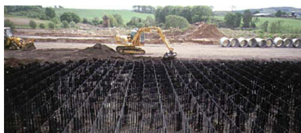
Việc lắp đặt lưới địa Geocell trên công trường rất nhanh chóng
