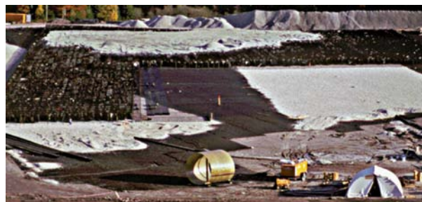
Công tác thi công lưới địa Geocell tại một công trường san đất (Đức)
