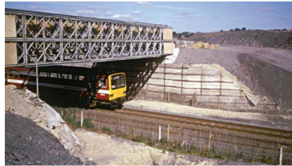
Mố cầu tạm thời sử dụng các panel lưới thép bề mặt
