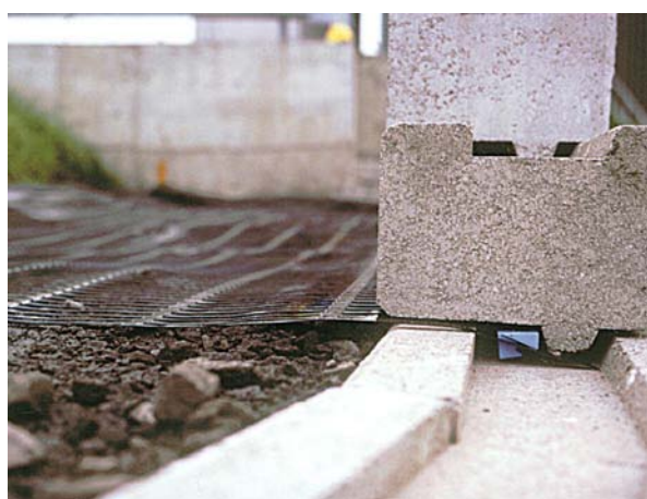
Lắp đặt các khối gạch block và phần lưới neo .
