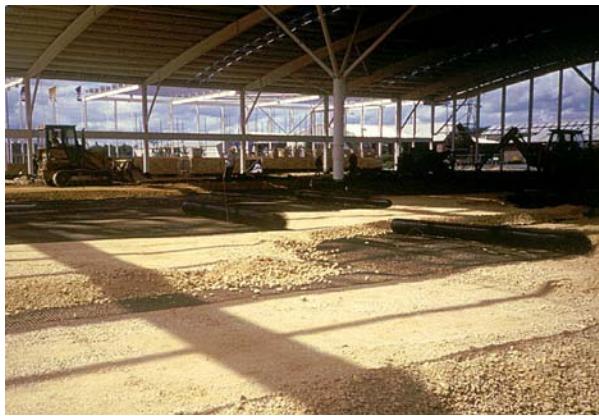
Hệ thống truyền tải trọng hỗ trợ thi công một sàn ghép bê tông ở dưới kết cấu khung bằng thép (Vương quốc Anh)
