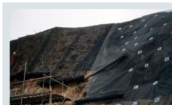
Lưới địa và lưới Tensar Mat thường được sử dụng để gia cố bề mặt các mái taluy đất soil-nailed
