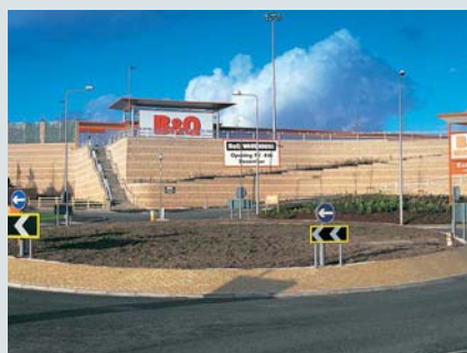
Tường chắn trong giai đoạn thi công
