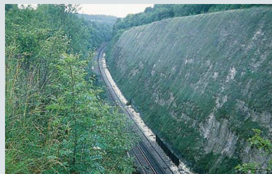
Thi công bề mặt mái taluy dốc bằng lưới và cỏ mang lại bề mặt xanh và chân đế vững chắc .
